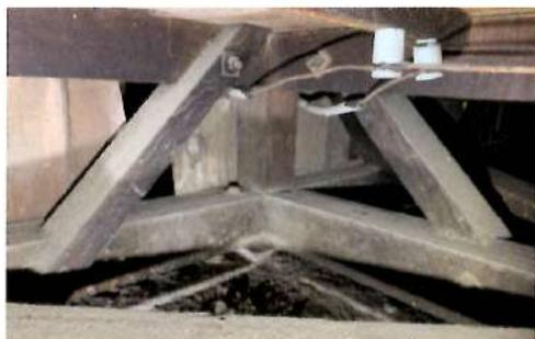
【図4】柱脚部分の耐震補強
