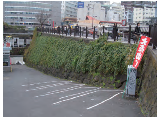
橋台石垣（市谷門）
