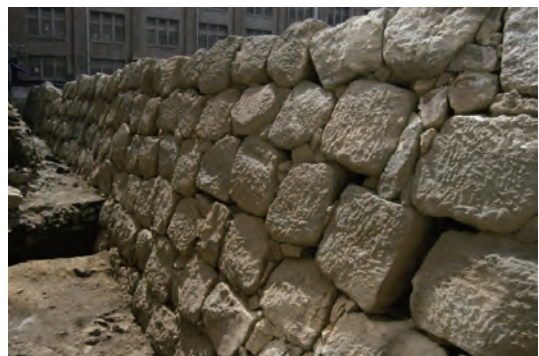
堀石垣（虎ノ門：旧文部科学省庁舎中庭部）
