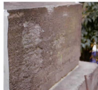
剥落と磨滅。風雪によって石が削られ、銘文が読めなくなっています。小さな破損から、広範囲の剥落に広がる可能性があります。
