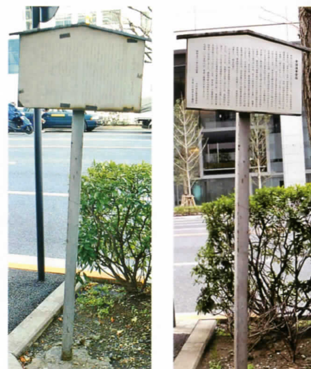
文字盤が劣化した「帝国議事堂跡」の説明板(霞が関一丁目3) (写真左)と貼り替え補修後の説明板(写真右)
