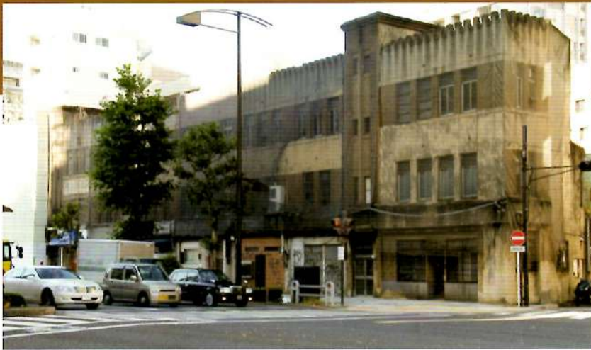
解体前の今川小路共同建築 千代田区広報広聴課提供（平成23年12月撮影）
