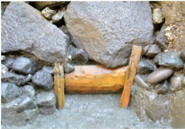
【写真4】 基礎に据えられていた胴木と杭
