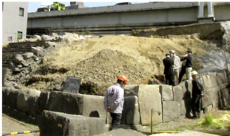
【写真1】 桁形石垣（北側）解体の様子
