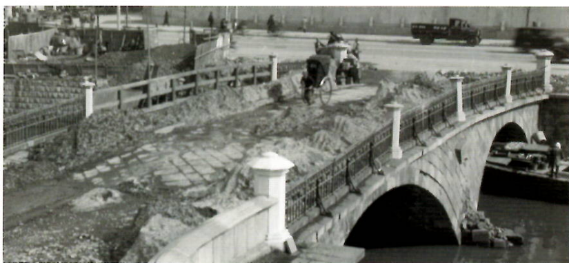
↑【写真3】「常盤橋修復前」 昭和6年（1931）撮影 （東京グリーンアーカイブス 所蔵）
